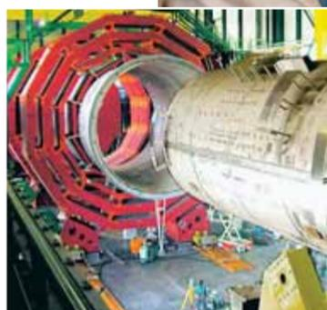
Einbau des CMS-Detektors (Compact Muon Solenoid) für das LHC-Projekt am CERN.
