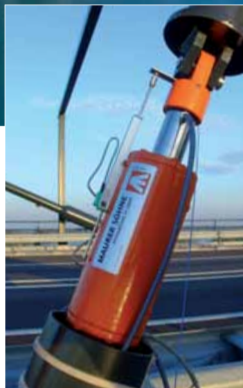
Regelbare magnetorheologische Fluiddämpfer sind Teil des von der Empa und der Firma Maurer Söhne entwickelten Dämpfungssysteme für die «Franjo Tudjman Bridge» in der Nähe von Dubrovnik, Kroatien.
