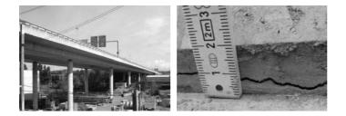
Figure 11. Viaduct Weyermannshaus, concrete crack (SWITZERLAND)
