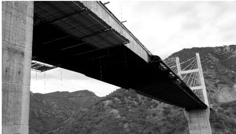
Figure 2. El Carrizo Bridge.
